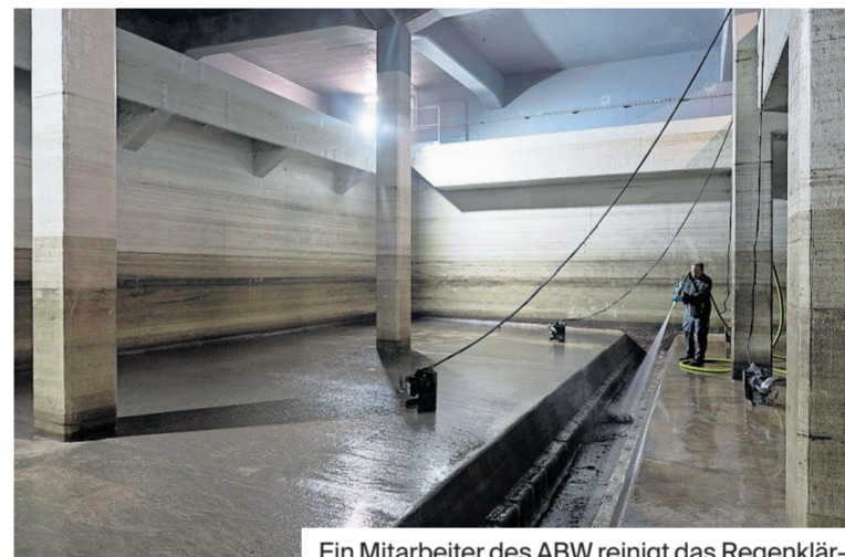
Ein Mitarbeiter des ABW reinigt das Regenklärbecken. Bild: Alex Spichale
