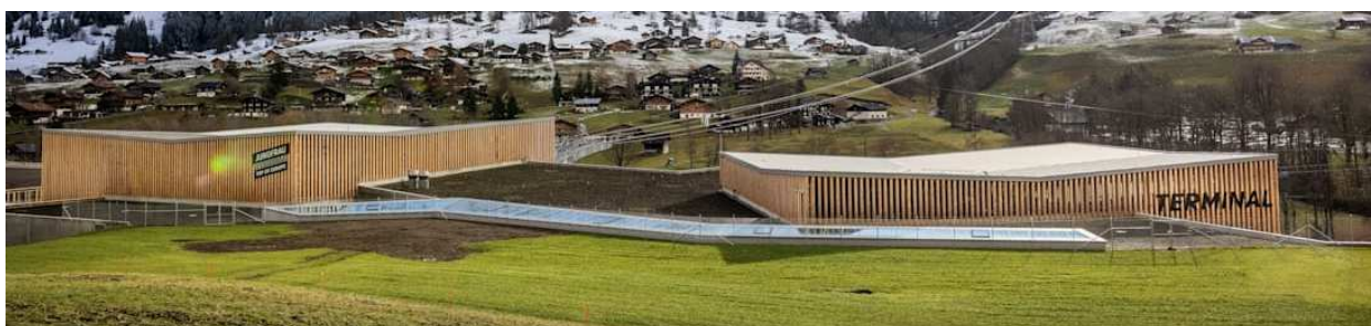
Neues Grindelwald Terminal
