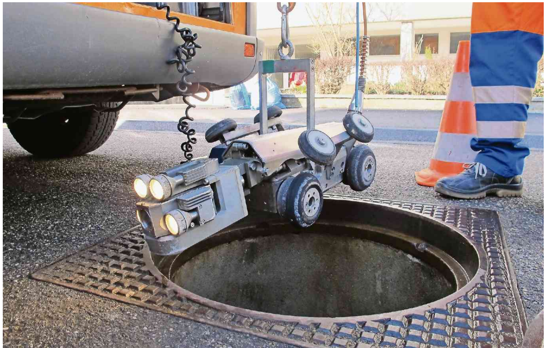
Ein Kamera-Roboter fährt durch die Leitung und liefert den Fachleuten Bildinformationen aus der sonst nicht einsehbaren Kloake.
