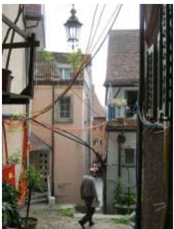
Werkleitungssanierung St. Niklausstiege Baden
