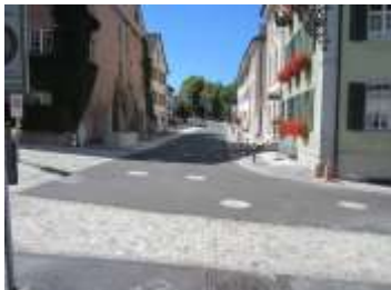
Pflasterung Rheingasse Kaiserstuhl
